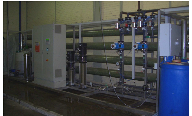
Ausgeführte Umkehrosmose-Anlage
